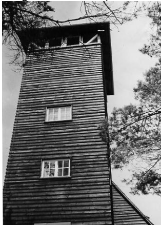
1971, Turm von Westen
