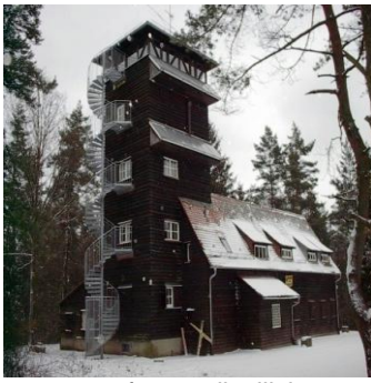
2001, feuerpolizeiliche Auflage, Fluchtreppe am Turm
