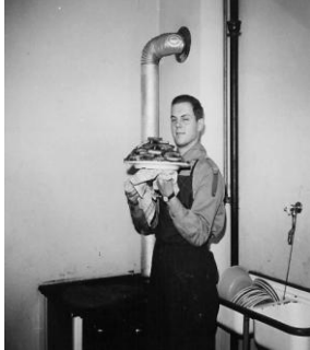
1964, Küche (noch im Erdgeschoss Turm) mit EWO
