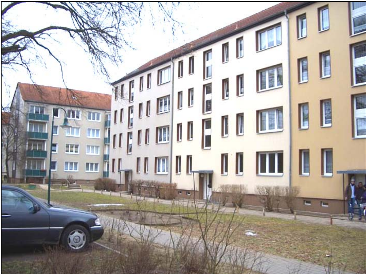
Alte Templinerstr. in Milmersdorf Quelle: Goltz, eigene Aufnahme
