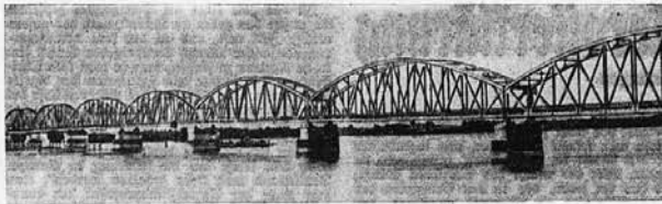
Die gewaltige Donaubrücke zwischen Belgrad und Fantschewo ist nach vierjähriger Bauzeit fertiggestellt worden. Die Brücke ist 1500 Meter lang, 11 Meter breit und dient dem Eisenbahn-, Fahr- und Gekverkehr. Das mächtige Bauwerk wird aber weit in den Schatten gestellt
