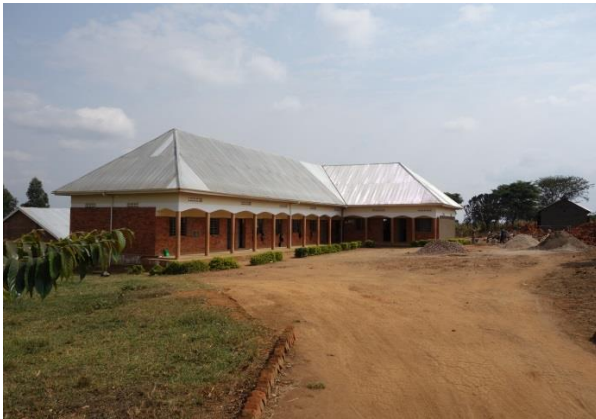
Bild 14 Zufahrt und Blick auf die Voc. Sec. School
