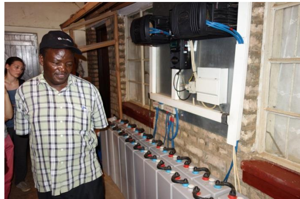
Bild 5 Batterieanlage bei Caritas Maddo
