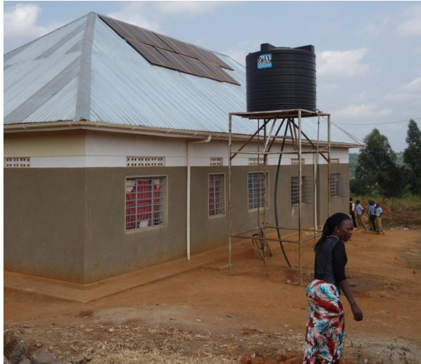
Bild 19 Hochbehälter Wassertank und Solarpanels
