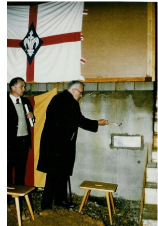
Okt.1973, Grundsteinlegung des späteren Kuratus Will Hauses, li. Bert Nowak
