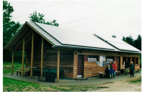
2001, das neue Sanitärhaus löst Freiluftwaschanlage und Plumpsklos nach 35 Jahren ab.
