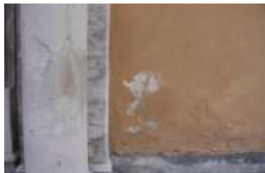
Schäden an Putz und Farbe, sowie an den Sandsteinen
